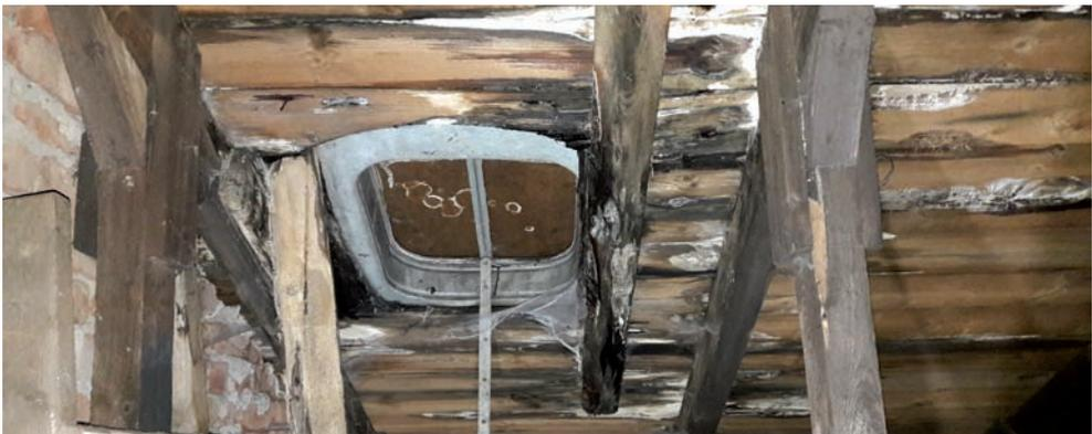
Die Fotos von Dach und Dachboden dokumentieren den maroden Zustand der Hölzer unter dem Dach. Ein Großteil ist schon abgefallen, teilweise ist nur noch die Dachpappe vorhanden. Behälter, um das eindringende Regenwasser aufzufangen, sind mittlerweile sinnlos geworden.
