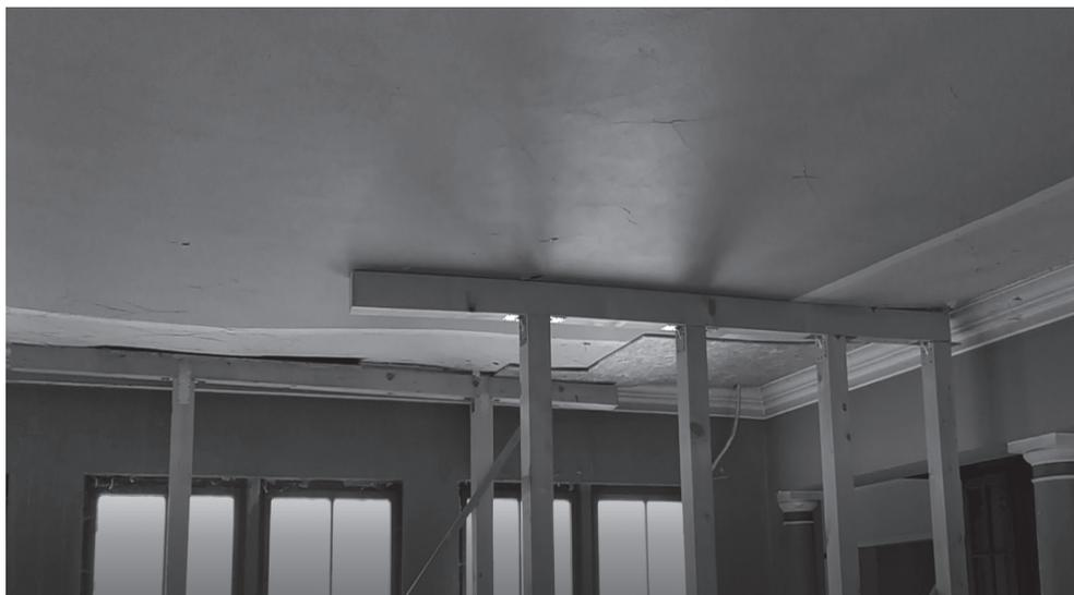
Auf einem der letzten Bilder, die wir machten – es ist das Obergeschoß, Zugang zum Foyer und Theatersaal – ist die Absenkung der Decke deutlich zu erkennen und die darin vorhandenen Risse. Die Fotos dokumentieren den Zustand der Bausubstanz. Die Schäden sind mittlerweile enorm.
