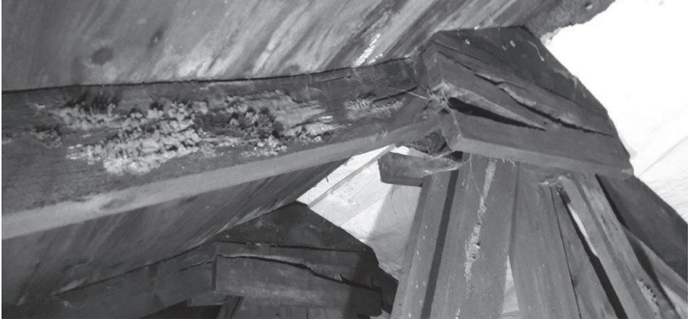
Das Wasser fließt ungehindert durch das Dach nach unten und die Feuchtigkeit breitet sich immer weiter aus. Das Foto zeigt, wie weit die Vernagelung schon aufgespalten ist. Der statische Druck auf den Nagelbindern ist so hoch, dass sich die Decke senkt. Im Treppenaufgang betrug die Senkung bei der letzten Messung schon elf Zentimeter.
