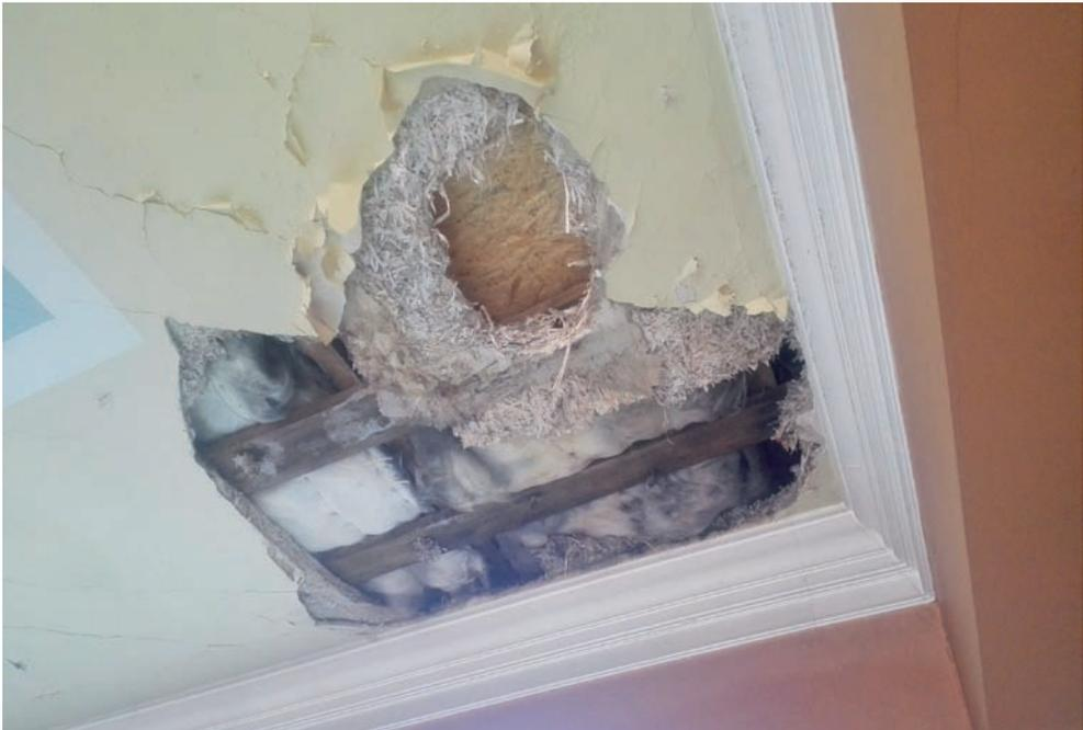
Zuerst fiel ein Teil der Decke herab. Um noch größeren Schaden zu verhindern, zogen wir weitere Deckenstützen ein, die das Saalfelder Holz-Zentrum spendete. Ohne diese Stützen wären die Dachbinder abgestürzt.
